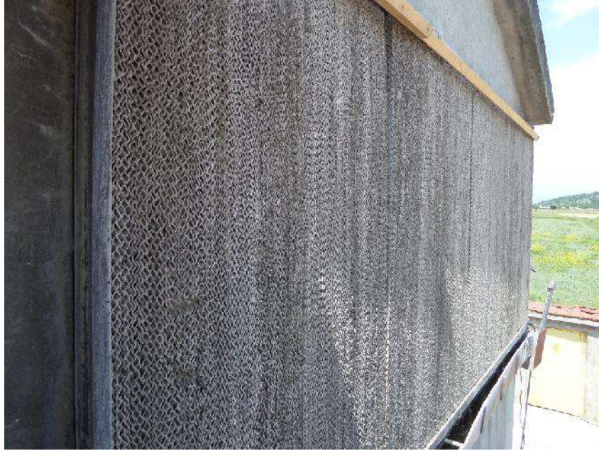
Slika 8. Sistem otvora-sa a koji služi za hlaenje
