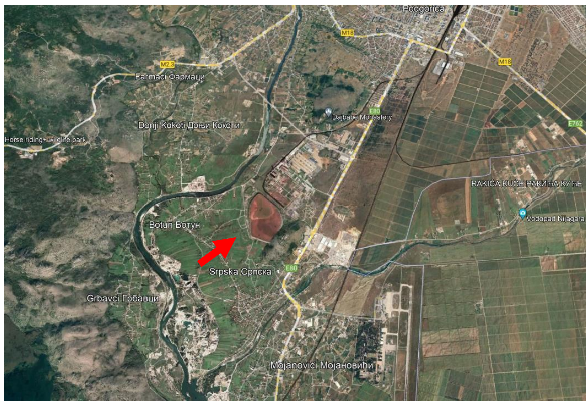
Slika 1. Geografski položaj lokacije solarne elektrane (označena crvenom strelicom)
